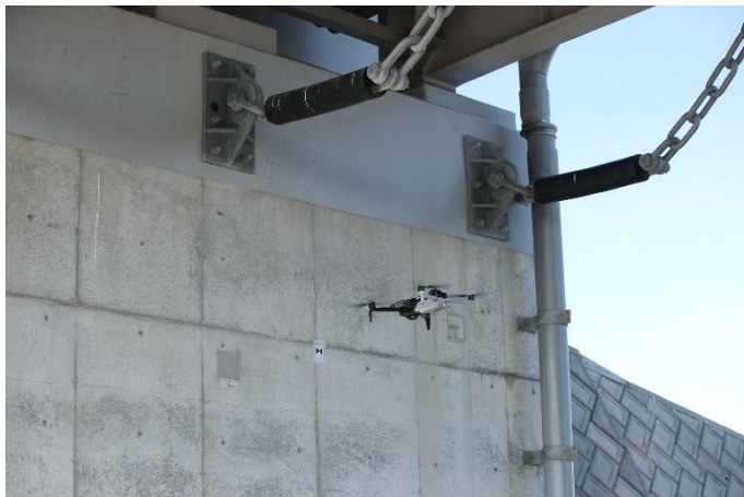
壁面にターゲットを張りTSで中心座標を取得。 三次元モデル・オルソ画像の精度検証に利用した。
