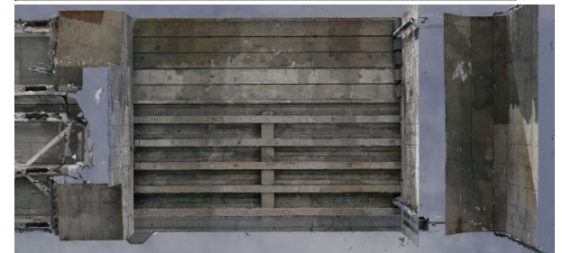
上部工の裏面も漏れなく3D化できている
