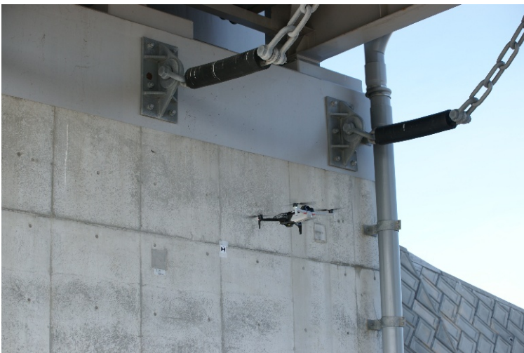
壁面にターゲットを張り、TSで中心座標を取得。 三次元モデル・オルソ画像の精度検証に使用。
