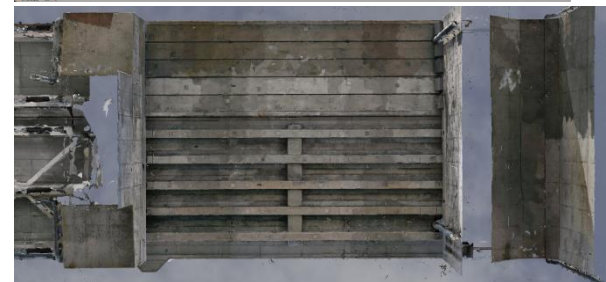
上部工の裏面も漏れなく3D化できている
